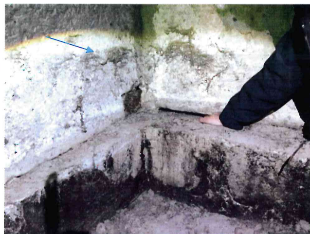
Фото №41,42 Отсутствие постели из раствора под внутренними продольными и поперечными панелями на пунктирных участках. Отметка высоты подтопления указана синей стрелкой
