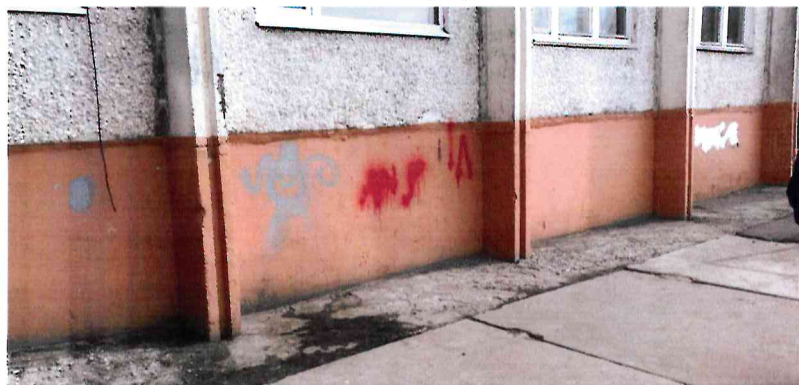
Фото №32. Фасад по оси Е-Е/1-6.
