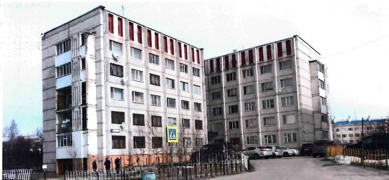
Фото №9. Главный фасад. Вид на жилые блоки Б, А здания №22 с ул. Набережная. Смотреть совместно с фото №1, №2, 8.
