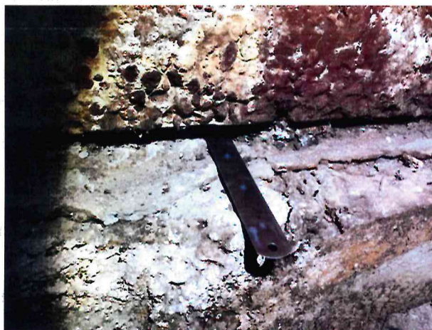
Фото № 39,40. Отсутствие постели из раствора под наружными панелями разрезкой по осям 3200 мм. Участки расположены под сквозными вертикальными трещинами в средней части пролета панели, размеры пустот на всю ширину панели высотой до 30мм и длиной до 1000мм.
