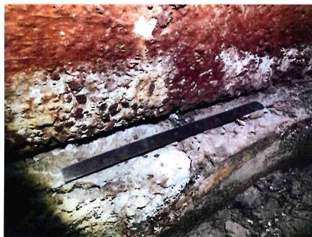
Фото № 39,40. Отсутствие постели из раствора под наружными панелями разрезкой по осям 3200 мм. Участки расположены под сквозными вертикальными трещинами в средней части пролета панели, размеры пустот на всю ширину панели высотой до 30мм и длиной до 1000мм.
