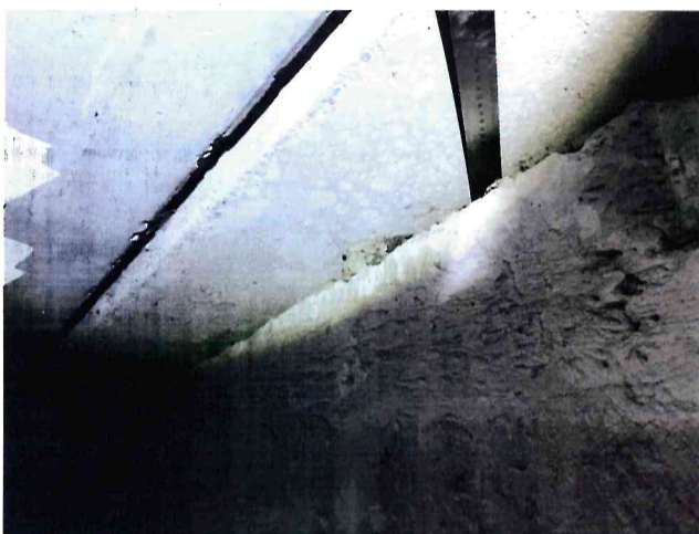
Фото №43,44. Отсутствие постели из раствора под внутренними продольными и поперечными панелями на пунктирных участках.
