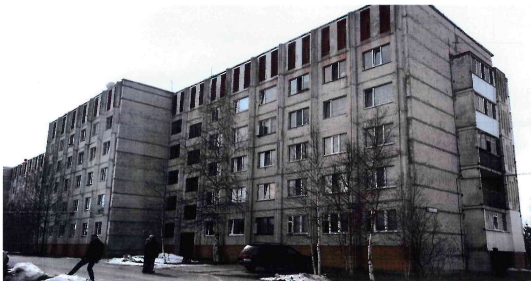
Фото №10. Дворовой фасад. Вид на здание №22. Блоки А,В. Смотреть совместно с фото №1,№2,№8.
