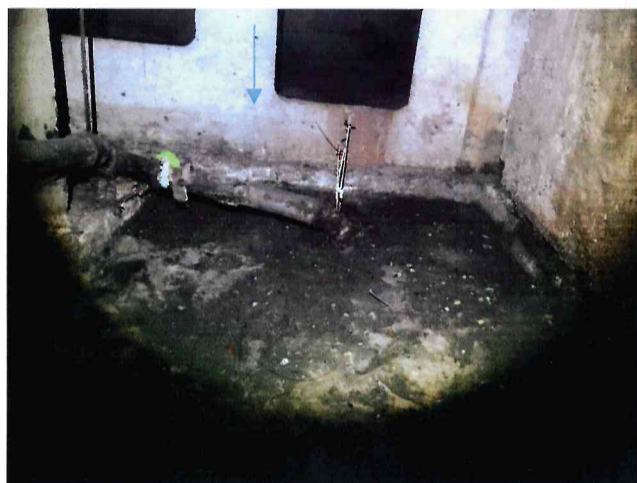
Фото №43,44. Отсутствие постели из раствора под внутренними продольными и поперечными панелями на пунктирных участках.
