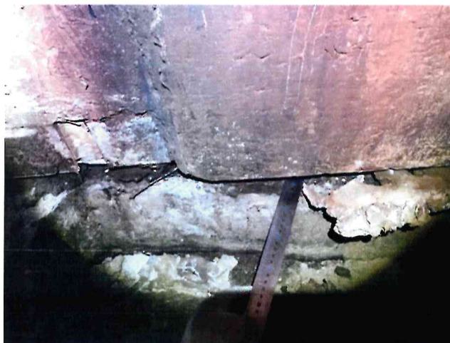
Фото №41,42 Отсутствие постели из раствора под внутренними продольными и поперечными панелями на пунктирных участках. Отметка высоты подтопления указана синей стрелкой
